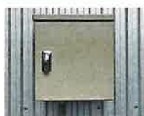
屋外ボックス安全ブレーカー
